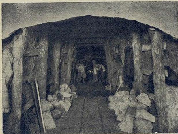
Galería de avance para la construcción de bóvedas de túnel
