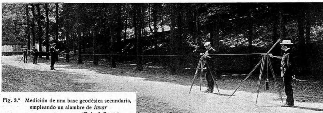
Fig. 3.\* Medición de una base geodésica secundaria, empleando un alambre de invar
