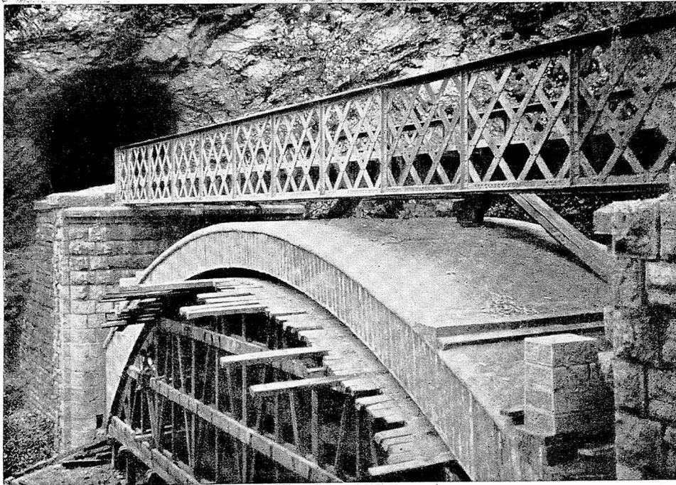
Puente de 25 m. de luz, en el Km. 41<sup>390</sup> de la línea de León a Gijón: Arco de hormigón en masa, en construcción, apoyado sobre su cimbra - El mismo arco descimbrado
