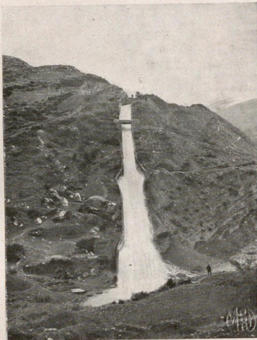
Fig 5.<sup>a</sup> Rampa de desagüe del depósito de carga
