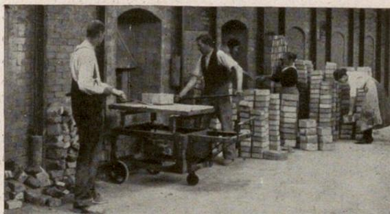
Fig. 7. Moldes de tierra refractaria para el recocido
