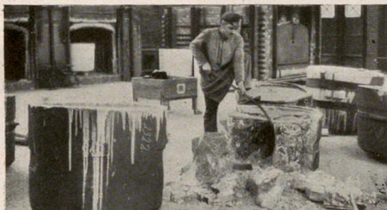
Fig. 5. Fractura de los crisoles en que se halla la masa
