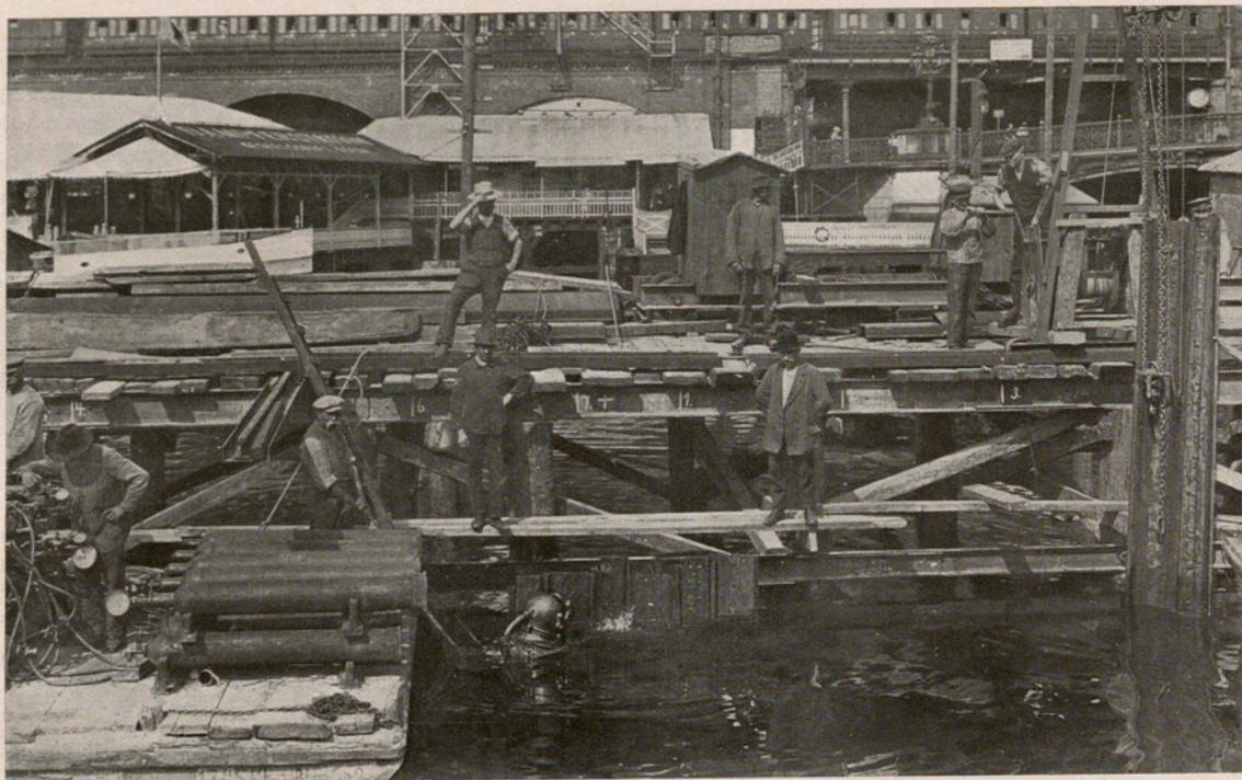
Fig. 6.\* Buzo empleando el novísimo sistema de corte oxhídrico submarino, patente alemana. Por este procedimiento se espera sacar los restos del transporte náufragó en los caños del arsenal de Cádiz
