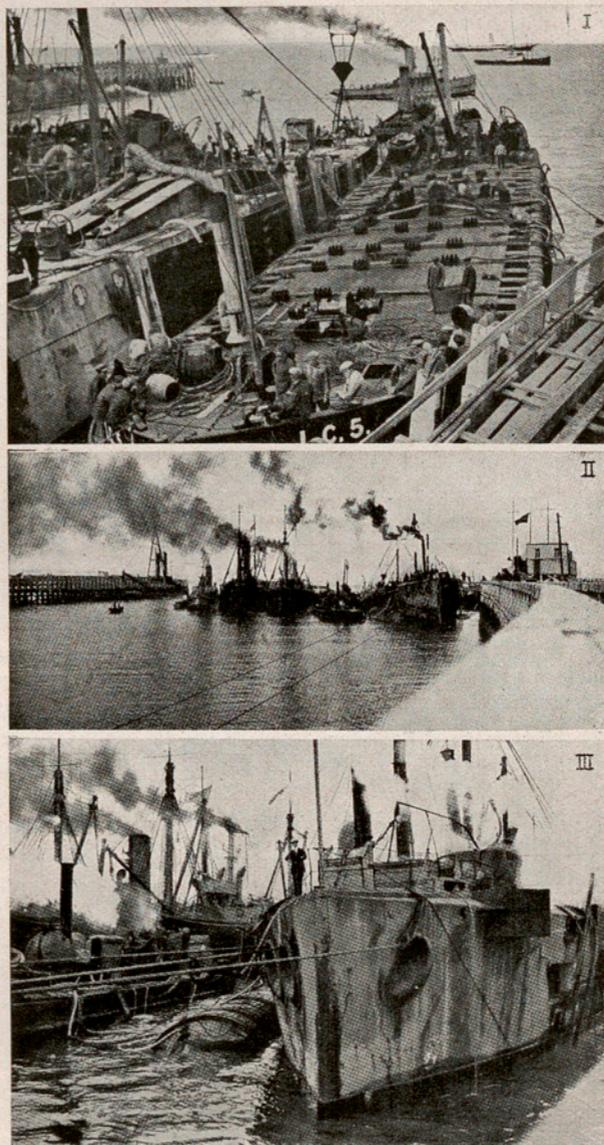
Fig. 10.<sup>a</sup> Salvamento del «Vindictive»: I. Afirmando pontones flotadores al casco en la parte quebrada - II. Vista general de las operaciones en los muelles de Zeebrugge - III. El «Vindictive» en posición de remolque
