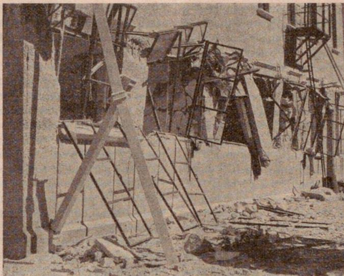
Seminario Católico Romano de Greenmeadows. Obra de tres pisos de hormigón armado. Los pisos superiores no deteriorados fueron apeados; el piso inferior estropeado fué despejado y se construyó de nuevo. Mano de obra excelente; las armaduras de acero no se rompieron en ningún sitio
