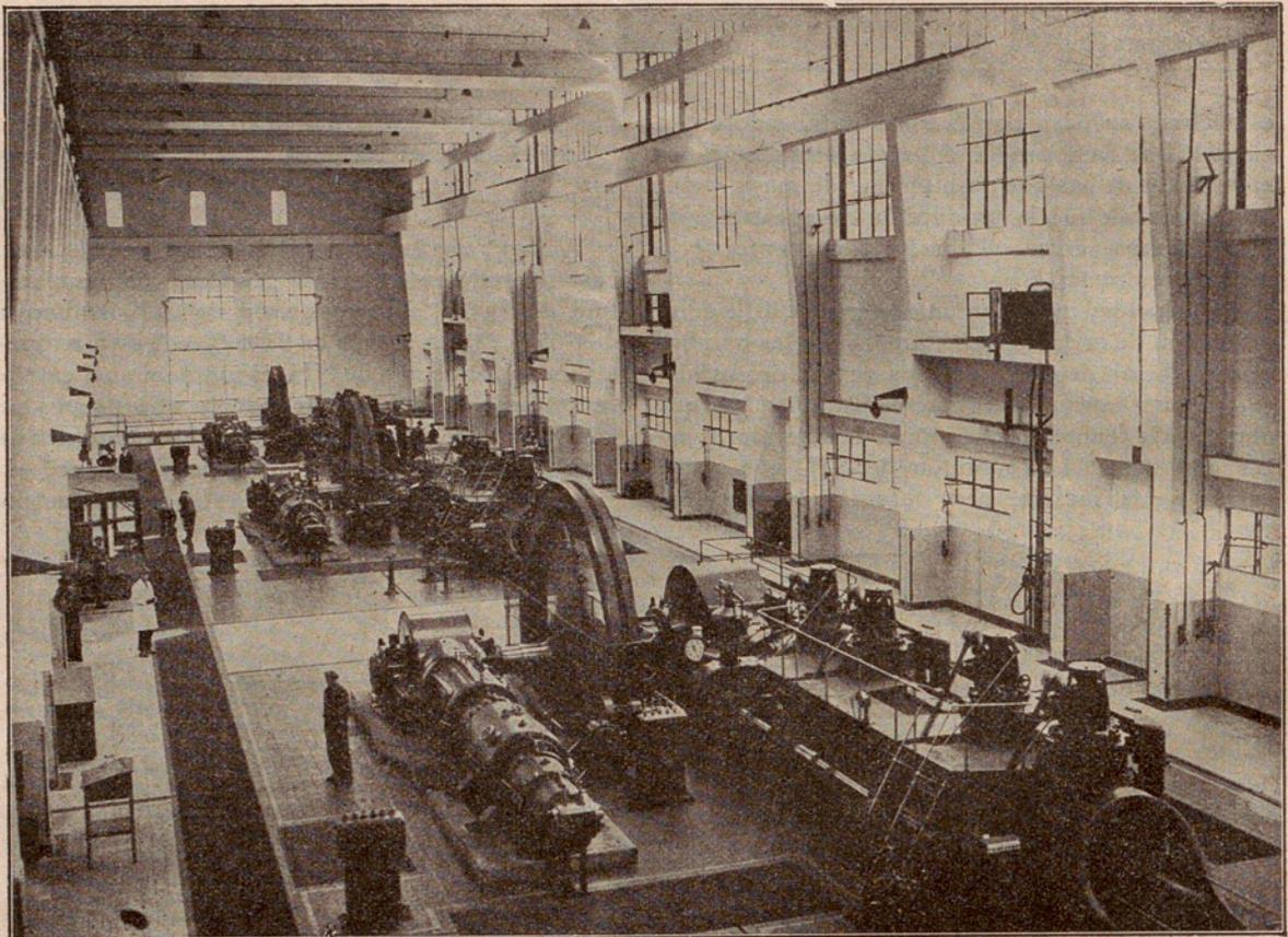
Fig. 8.ª Compresores movidos por máquinas de gas, que comprimea la mezcla de síntesis de 10 a 300 atmósferas
