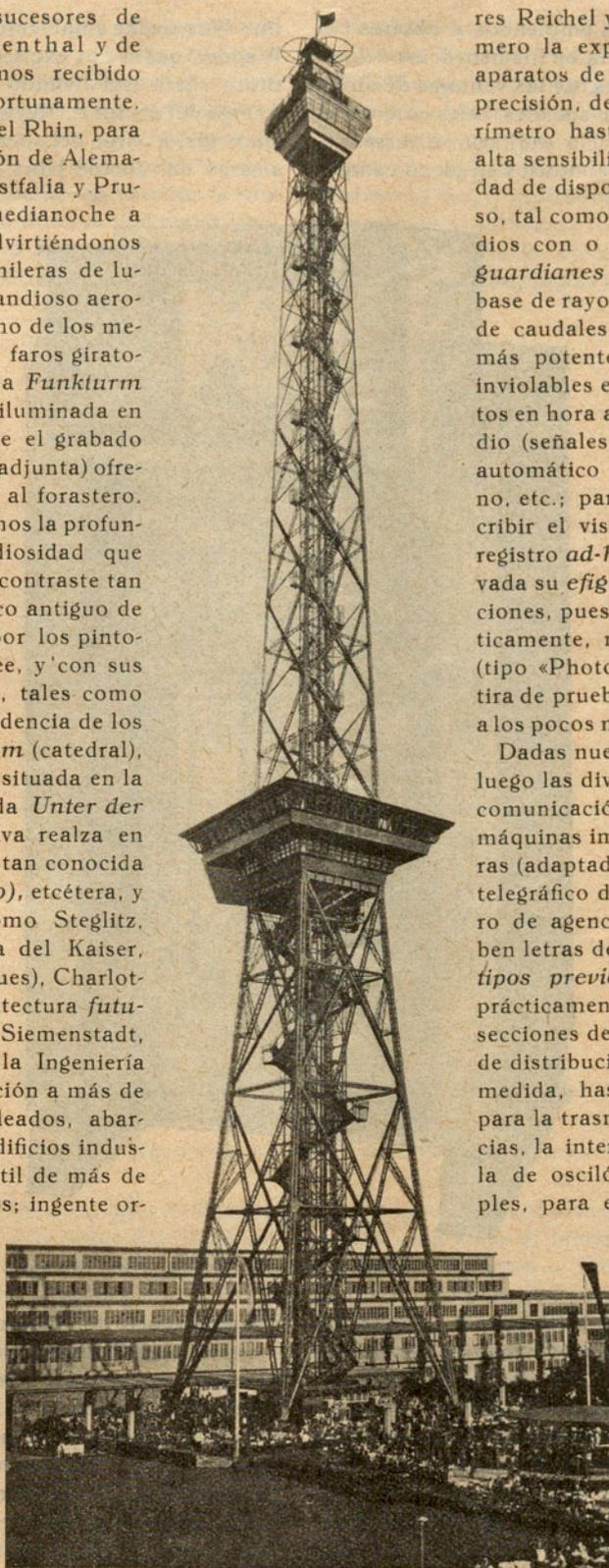
Fig. 2.ª La Torre de la Radio (*Funkturm*) con los edificios de la Exposición: en la cúspide son visibles las antenas anulares especiales para emitir las ondas ultracortas de televisión; allí se hallan instalados los faros giratorios
