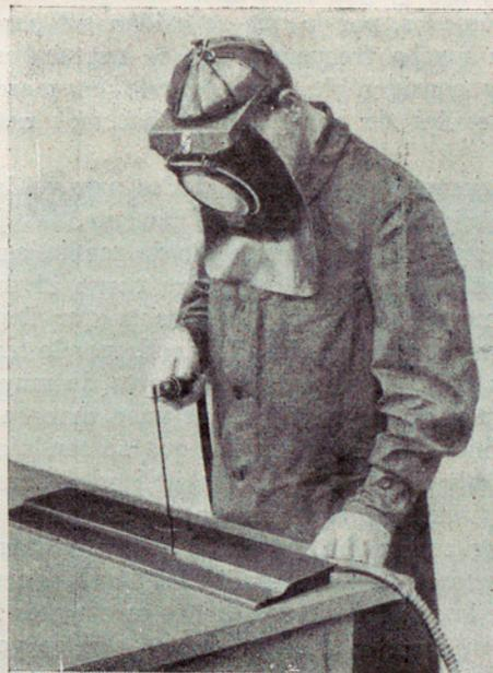
Fig. 4.—Máscara de protección para soldar.
