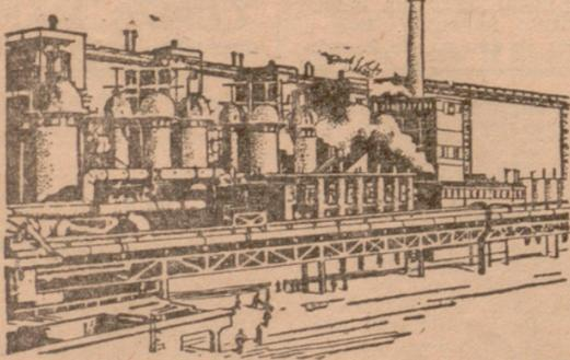
de destilación de hulla, para la fabricación de gasolina sintética, de mas de 1.500.000.000 de m.<sup>3</sup> teóricos de gas sintético de capacidad, fue construida por la casa KOPPERS de Essen (Renania), según sistema de Fischer-Tropsch. Esta instalación consta de siete instalaciones de las que solo cinco se ven en la figura.
